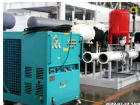
中央空调工厂冷媒回收加注
