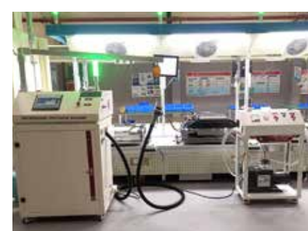
汽车空调冷媒加注
