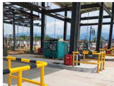
制冷剂余气回收现场
