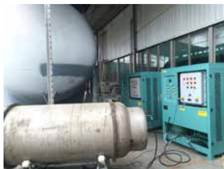
制冷剂余气回收现场
