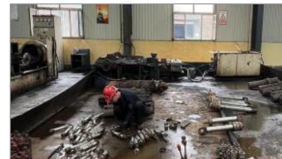
Зона демонтажа цилиндров
