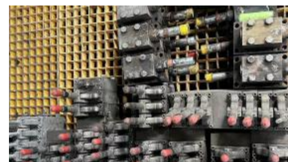
Зона ожидания ремонта
